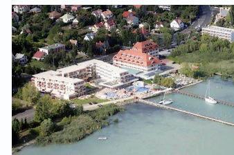
BALATONFÜRED, HOTEL FLAMINGÓ
